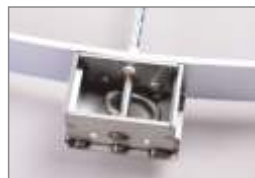
instalacja puszek na kole DC-250_DT oraz S-243_DT
