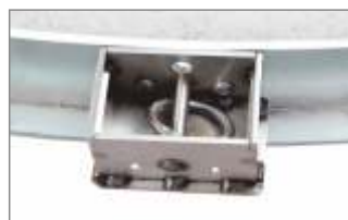
instalacja puszek na kole DCP19-250 oraz SCP19-2135
