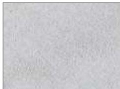
Hochwertige Betonoberfläche im Innenkreis
