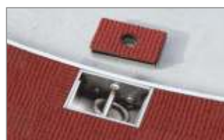
im Bodenbelag installierter Kasten
